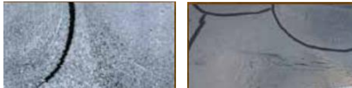
(d) Hook Cracks
