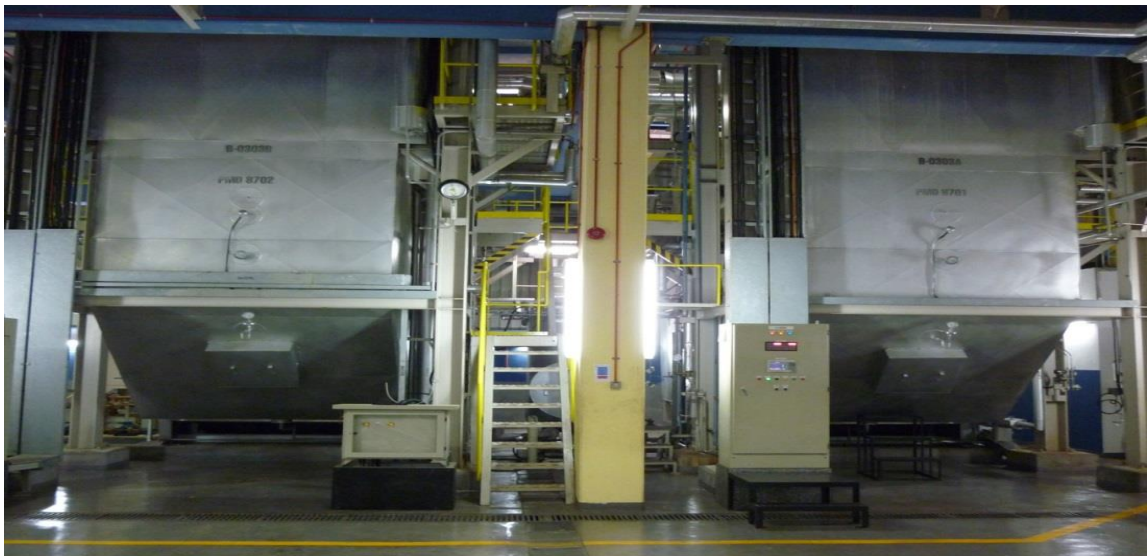
Figure 1.1: HRSG in UTP GDC plant
