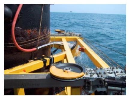
FIGURE 4 DIAMOND WIRE SYSTEM (SNYDER & BYRD, 2004)
