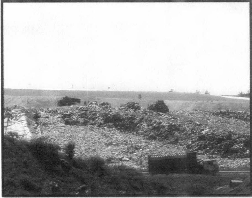
Figure 3 : Bukit Tagar Landfill
