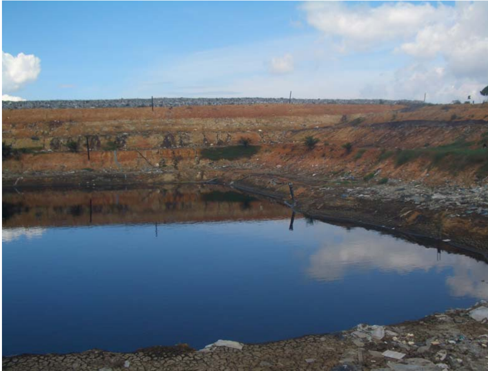
Fig. 3.1 Pulau Burung Landfill Leachate Collection Pond
